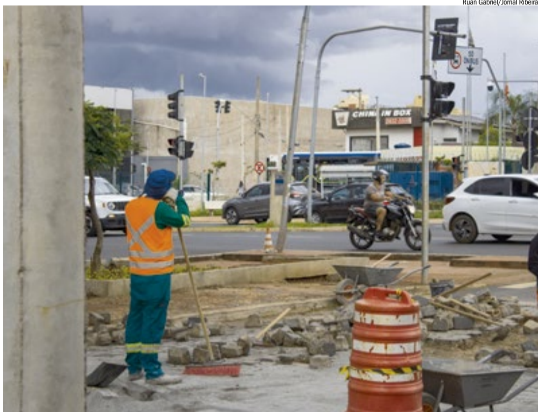
Trabalhador faz pausa em intervenção na avenida: trecho está interditado há mais de uma semana
