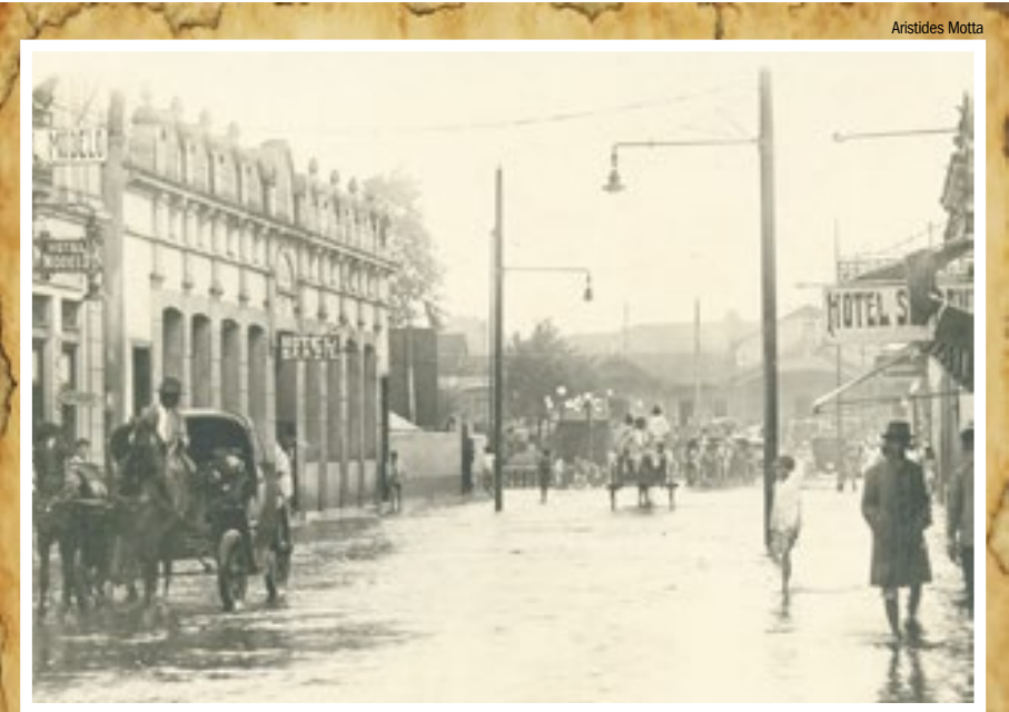
PROBLEMA ANTIGO - Com o hotel Brazil ao fundo, foto de Aristides Motta mostra a região da rua General Osório, na baixada central, após a grande enchente de 1927. No passado como no presente, a região - antes um grande alagado natural - é uma das mais atingidas pela força das águas do ribeirão Preto.
