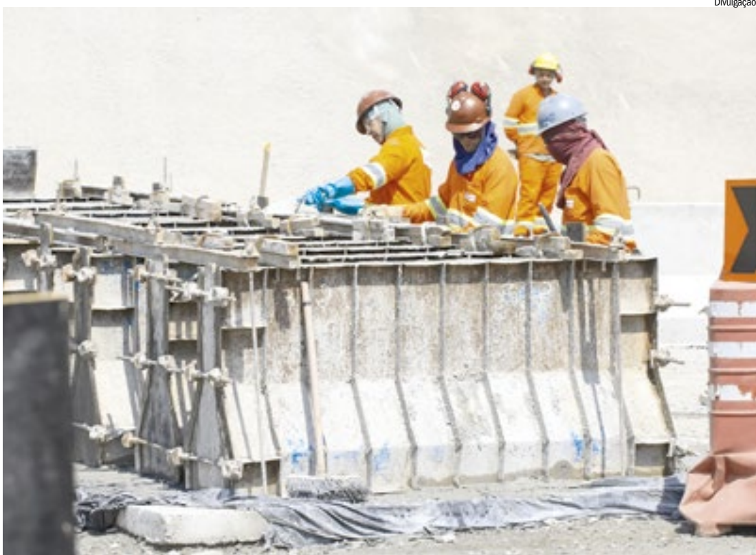
Funcionários trabalham em obra: construção civil é um dos setores com destaque na geração de empregos
