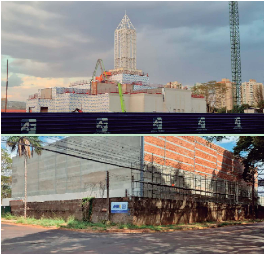
Acima construção da Igreja de Jesus Cristo dos Últimos Dias, abaixo Igreja Campos Eliseos no Recreio das Acácias
